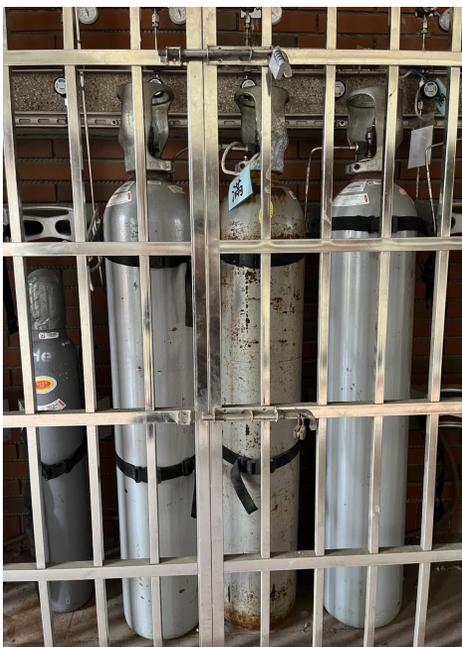
▲圖2 高壓氣體鋼瓶固定
