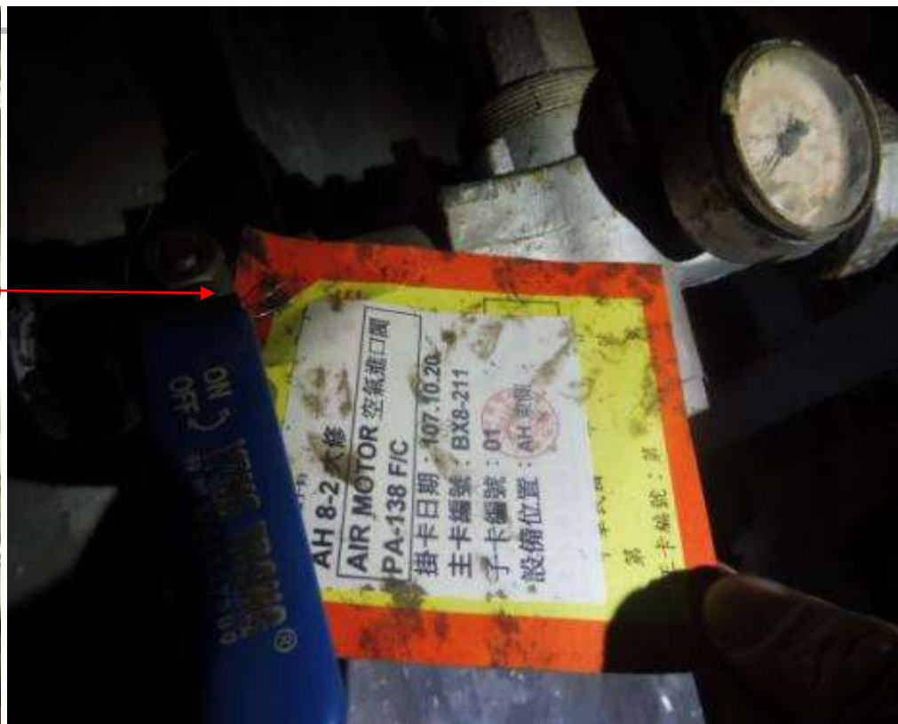
附照4- 氣動開關處所掛之停機掛牌標示不清(即張貼內容已遮蔽「作業中禁止操作」字樣)
